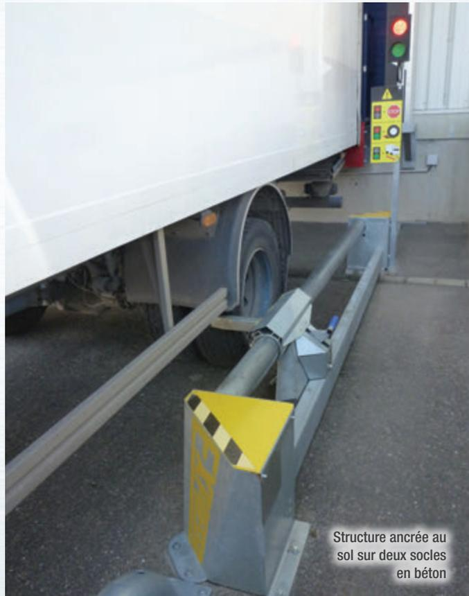
Structure ancrée au sol sur deux socles en béton
