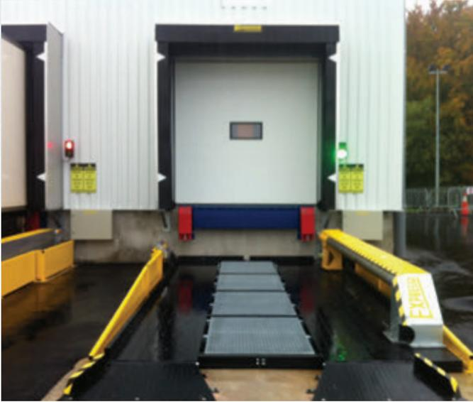
Les rehausses hydrauliques permettent de soulever ou d'abaisser l'arrière du camion, donc de régler à volonté la hauteur et l'inclinaison du plancher de chargement. Leur mise en place ne nécessite pas de génie civil. Livrées prêtes à l'installation, avec coffret électrique intégrant les commandes "levée-descente".
